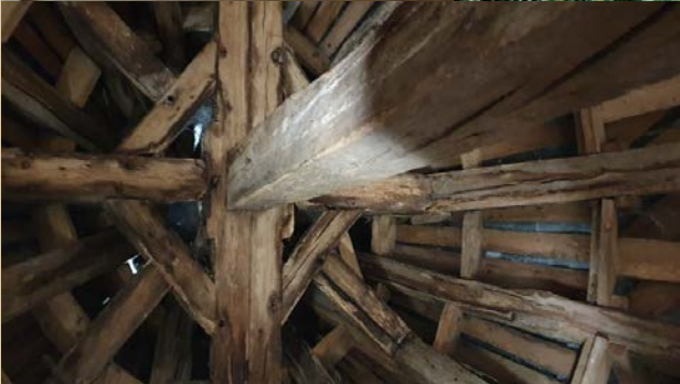
Escalier classé et charpente de la toiture en ardoises de la tour ronde du château
